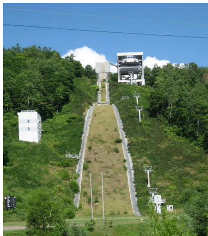
写真-6 小樽市望洋シャンツェ (平成10年完成 建設費14億円) (平成28年4月 廃止) 現在、キャンプ場として利用 (ヤフー画像より)
