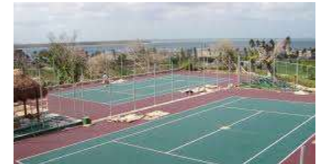
写真-14 既設ハードコートを改修 (ヤフー画像より)
