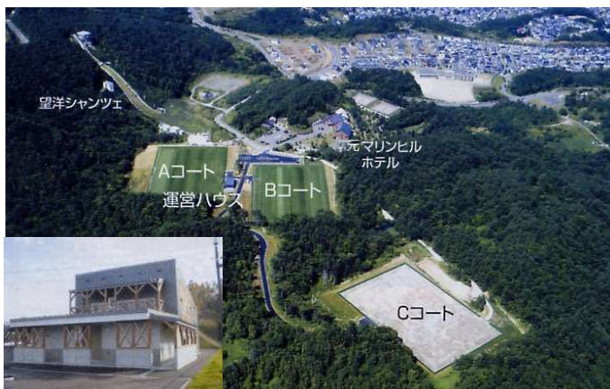
写真-7 小樽市望洋サッカーラグビー場&管理棟 (平成16年完成 建設費12億5千万円) (小樽市HPより)
